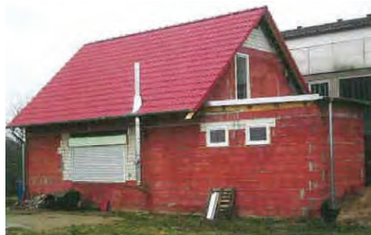
Wird schon für Aktivitäten rund um den Volleyball genutzt, der Beach-Club im Rohbau!
