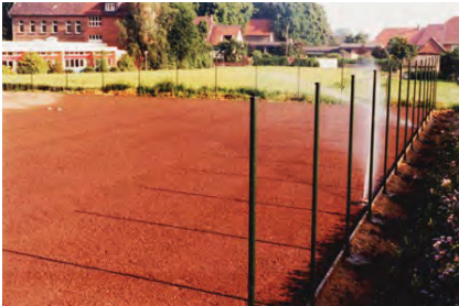
Die Tennisplätze entstehen
