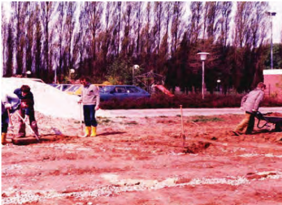
Arbeiten an der künftigen Anlage
